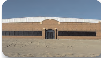
BENSHAW Pueblo Trane Division Pueblo, CO
